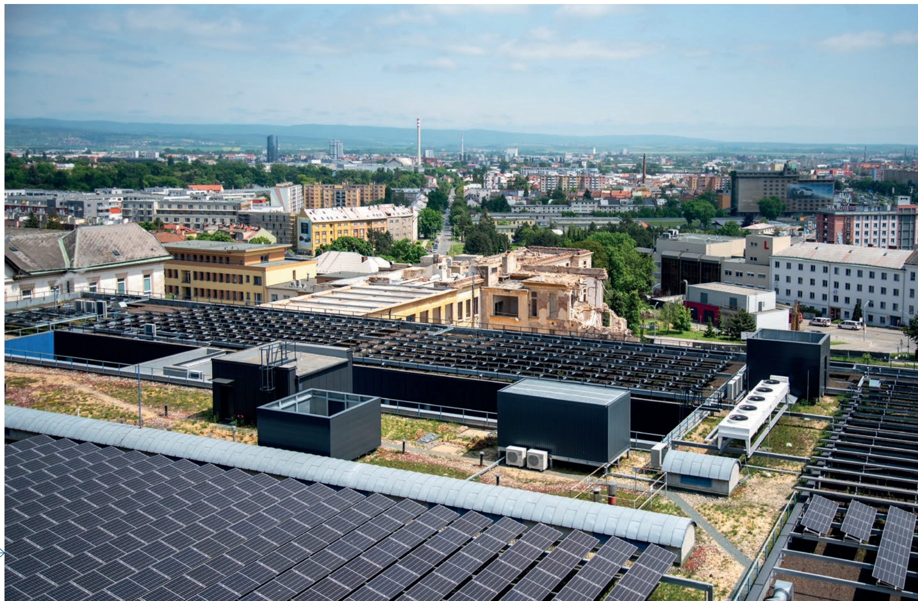
Fotovoltaické panely na budově A.
